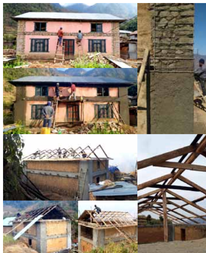
Les cases reforçades gairebé acabades, amb cantonades armades i diagonals de fusta afegides.
