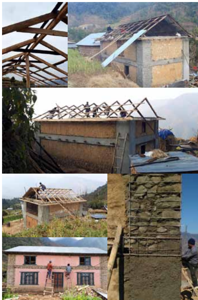
Les cases reforçades de Supin gairebé acabades, a falta d'executar totes les diagonals de fusta.
